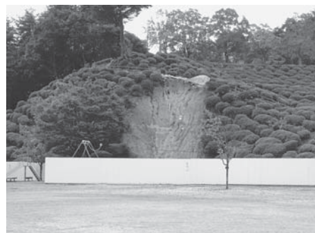
〈豪雨により崩落した斜面の様子〉
