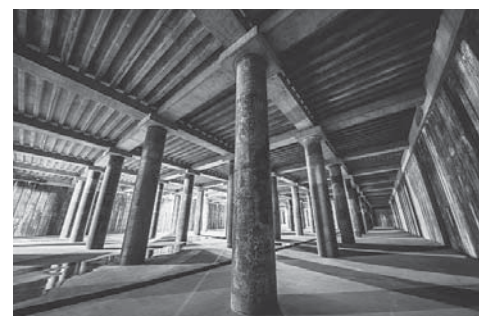
〈山王雨水調整池の様子〉
